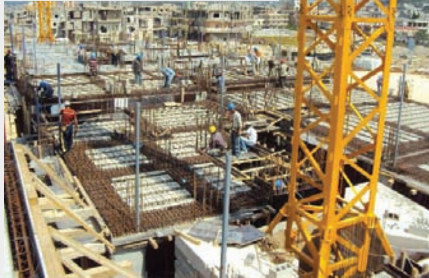
بدء إعادة عملية الإعمار
